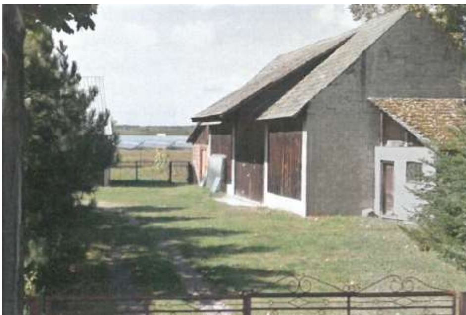
Zdjęcie 12 Widok na instalację fotowoltaiczną z odległości ok. 140 m.
