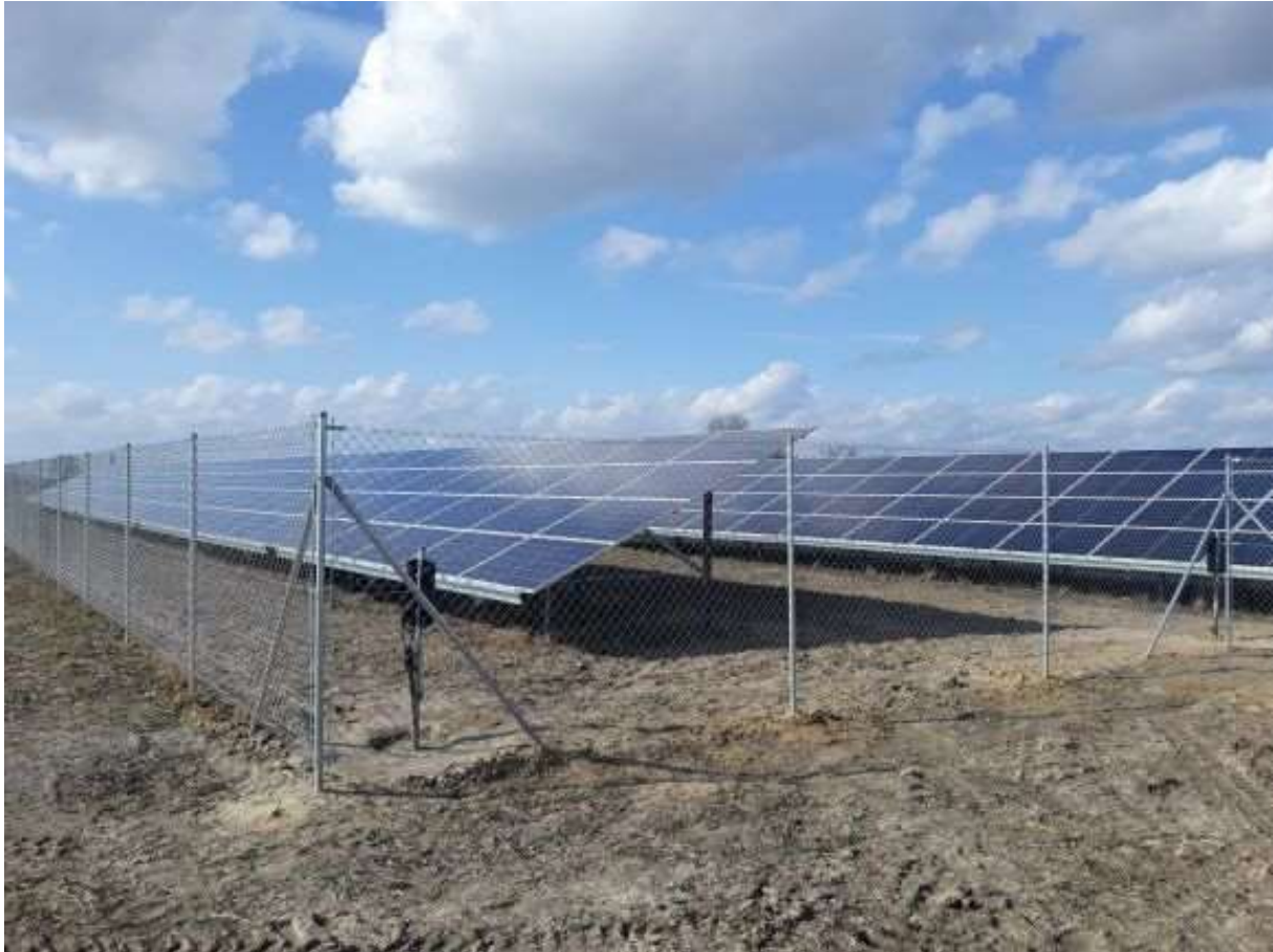
Zdjęcie 9 Przykładowe ogrodzenie farmy fotowoltaicznej.
