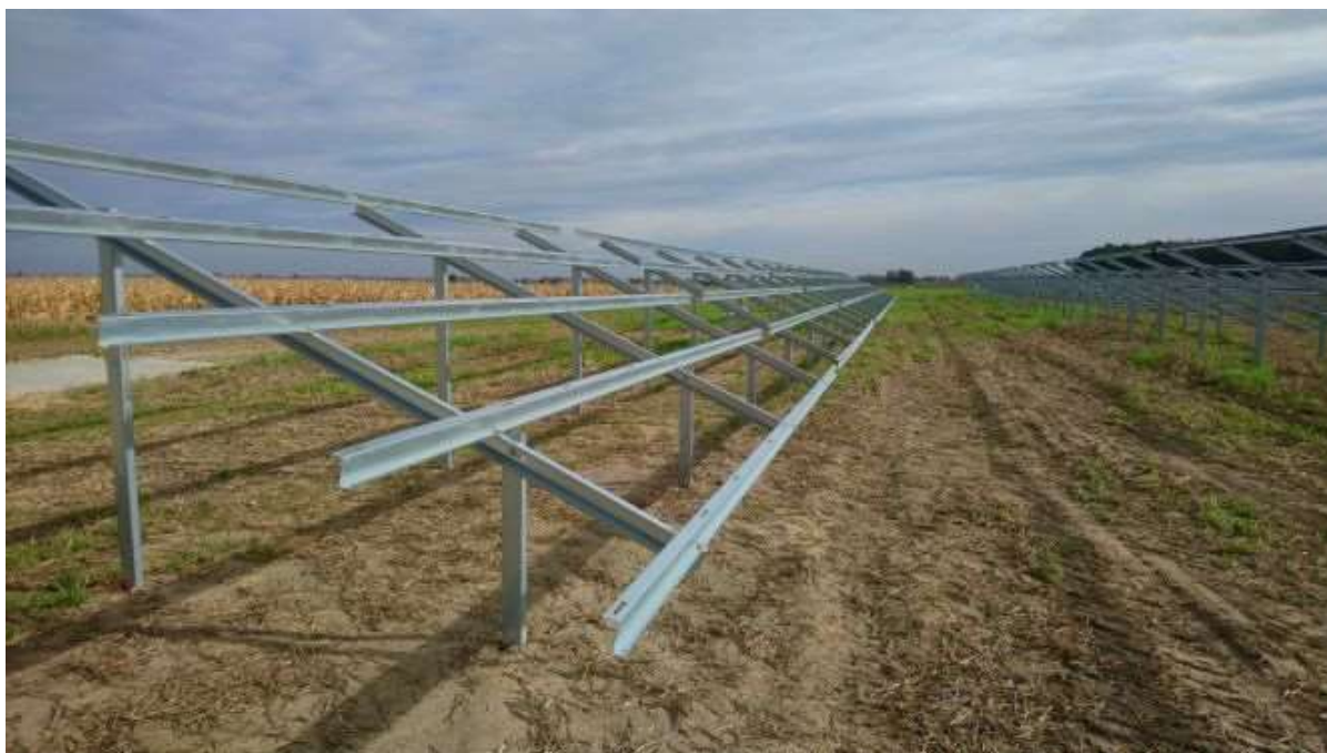
Zdjęcie 10 Szkielety przed montażem paneli.
