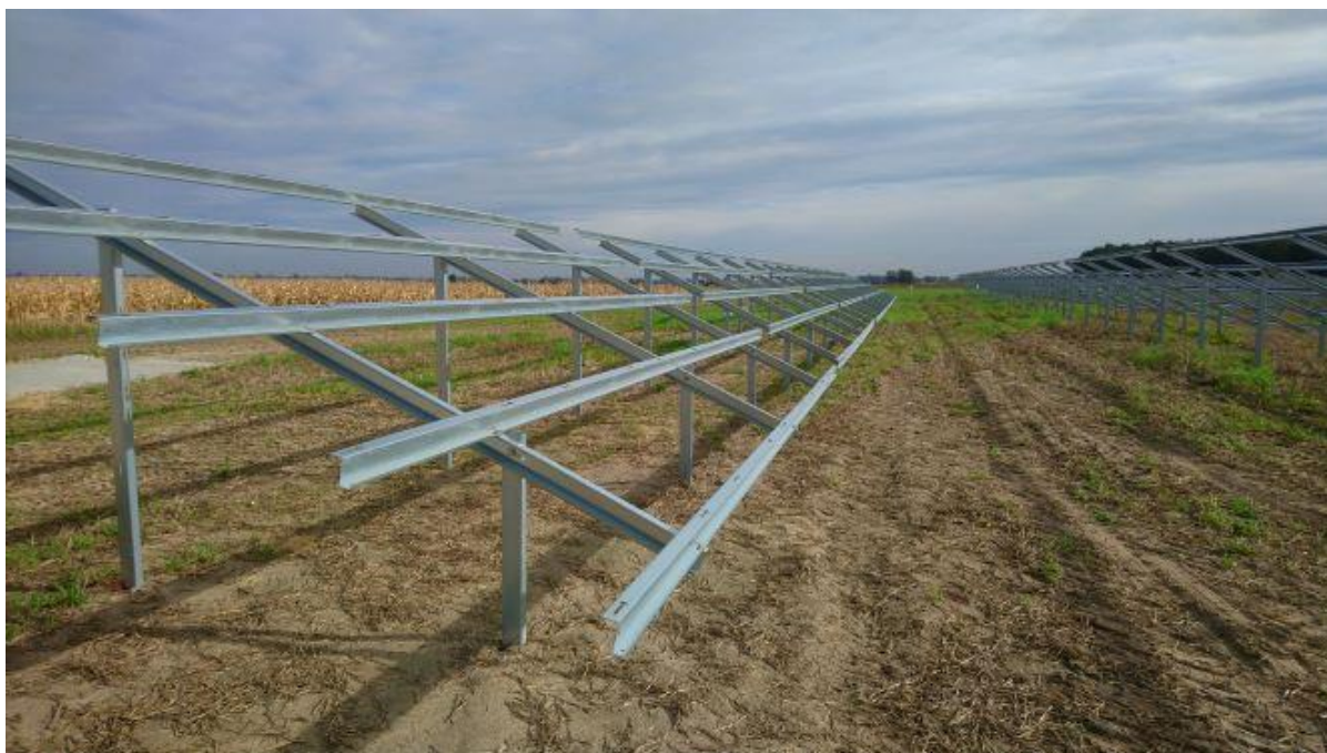
Zdjęcie 10 Szkielety przed montażem paneli.
