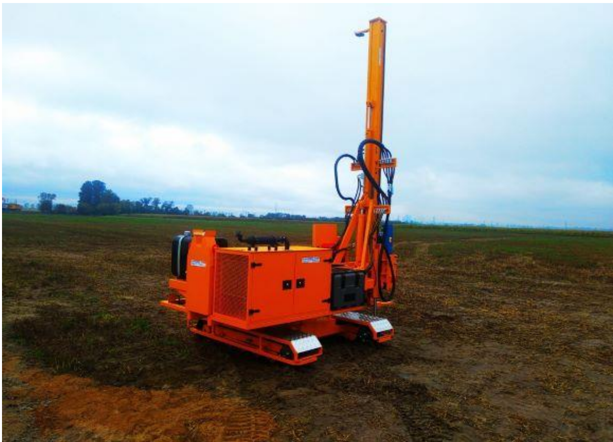
Zdjęcie 2 Budowa konstrukcji za pomocą kafara.
