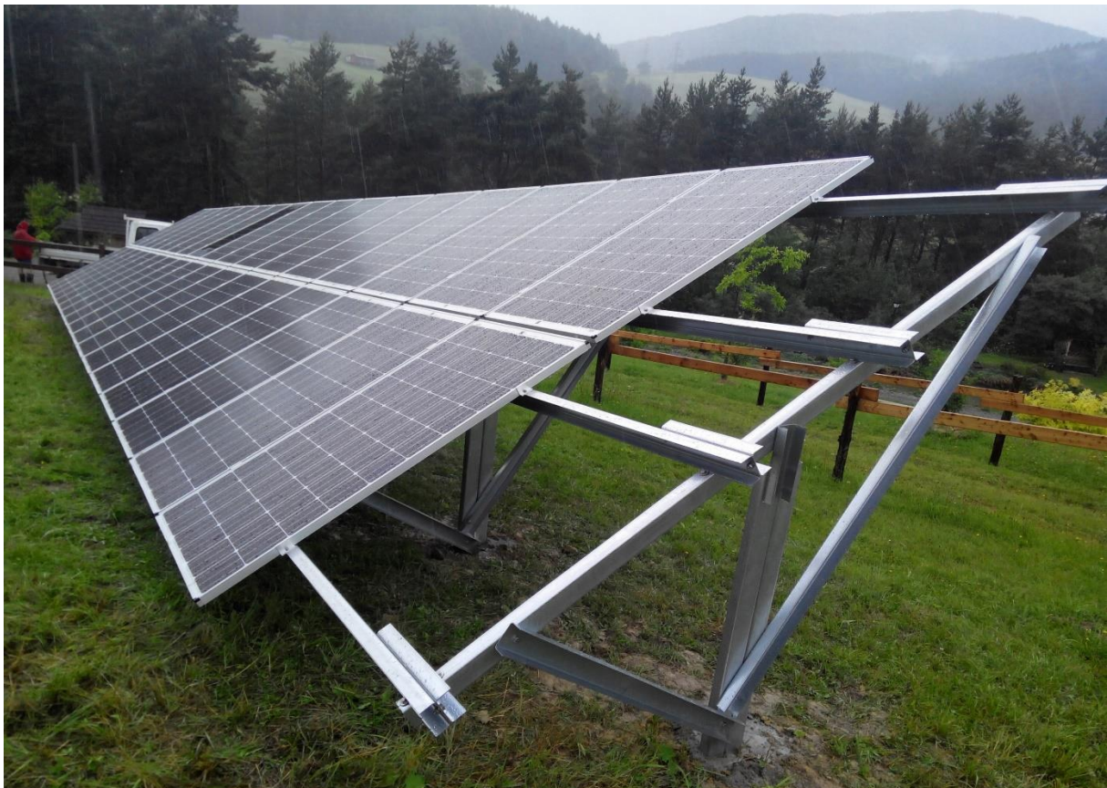
Rysunek 1 Schemat konstrukcji stelażu nośnego dla paneli fotowoltaicznych.
