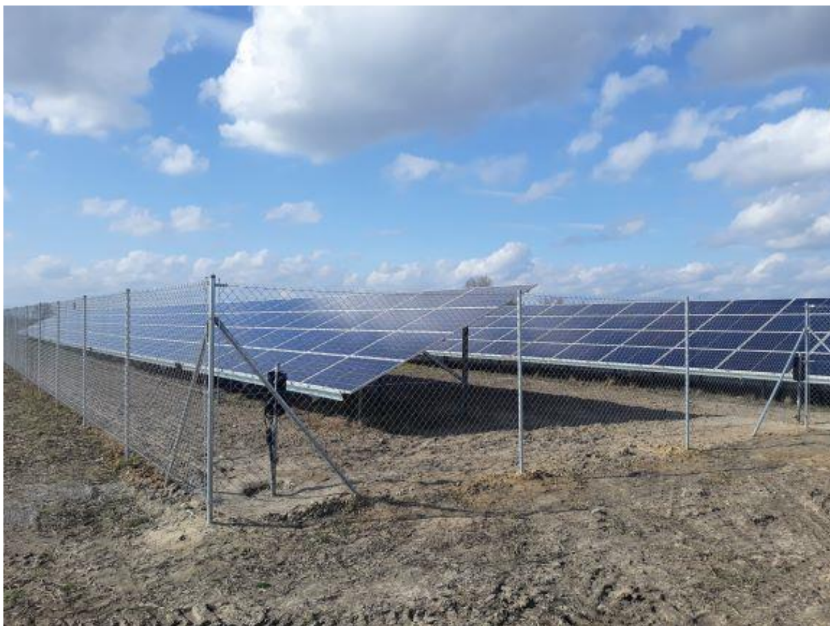
Zdjęcie 9 Przykładowe ogrodzenie farmy fotowoltaicznej.
