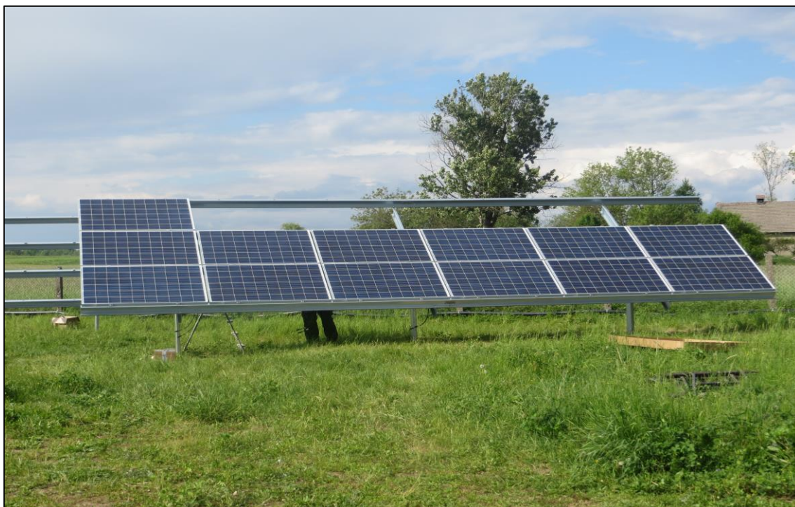
Fot. 5. Montaż paneli na konstrukcji stalowej
