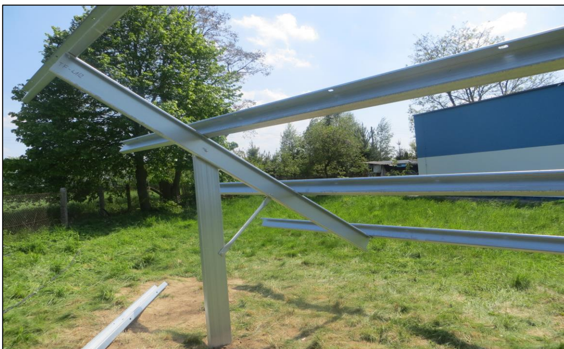
Fot. 3. Montaż konstrukcji stalowej
