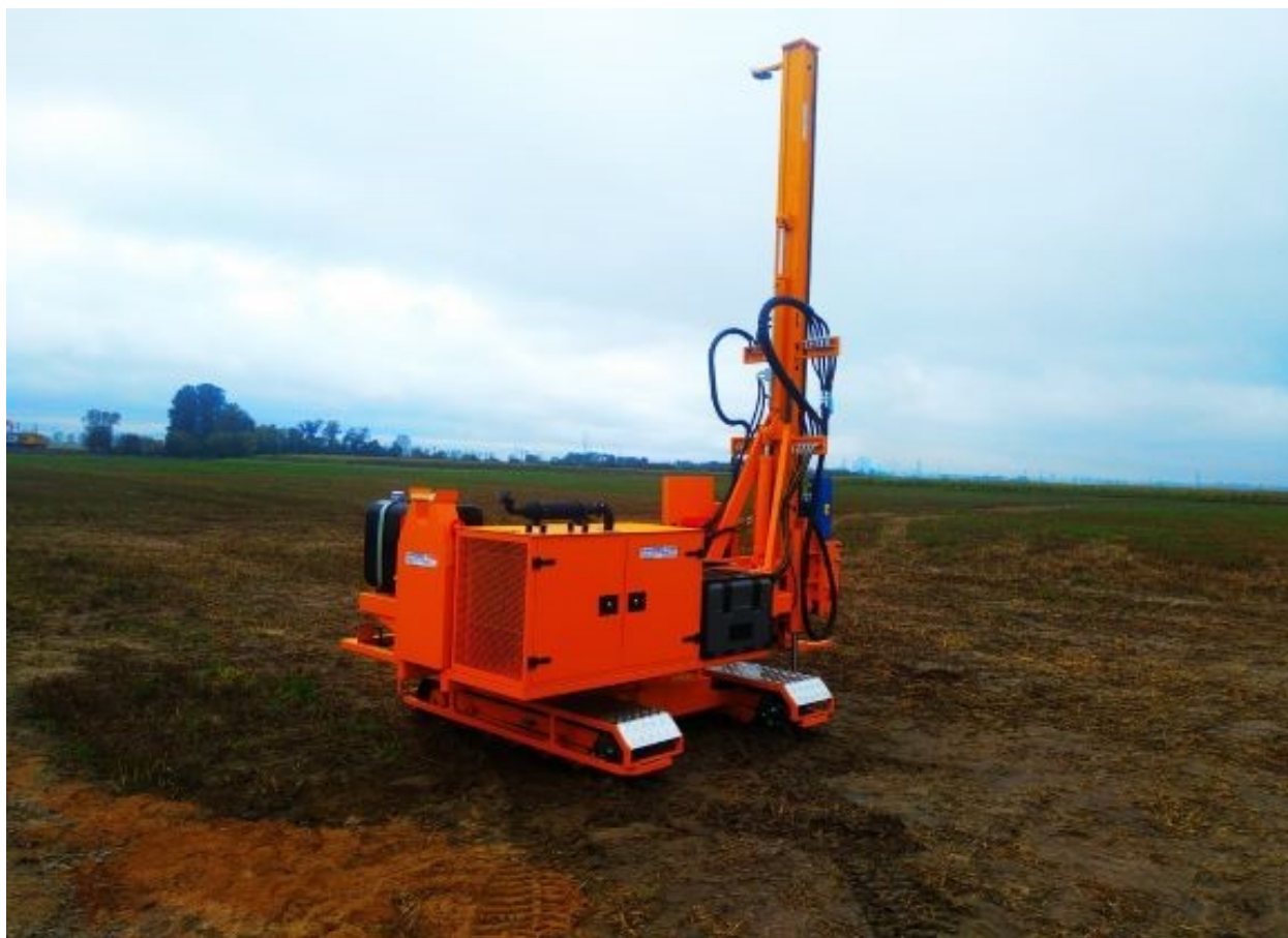
Rycina 4 Budowa konstrukcji za pomocą kafara.
