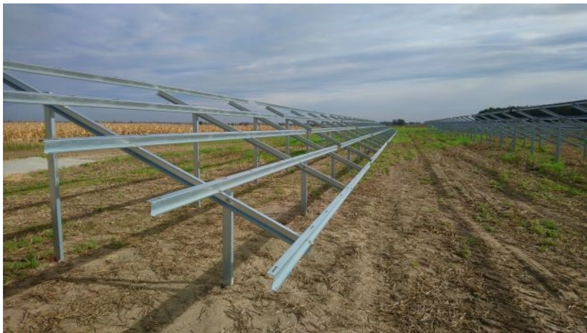
Rycina 14. Szkielety przed montażem paneli.
