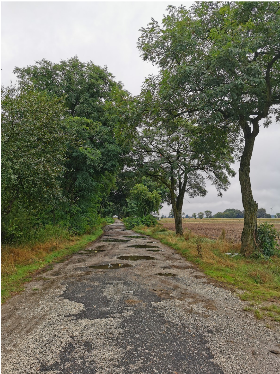
Fot. 1 Widok na drogę (poza terenem opracowania)
