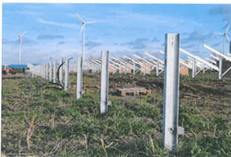
Zdjęcie 1 Profile metalowe: podstawowy element konstrukcji.
