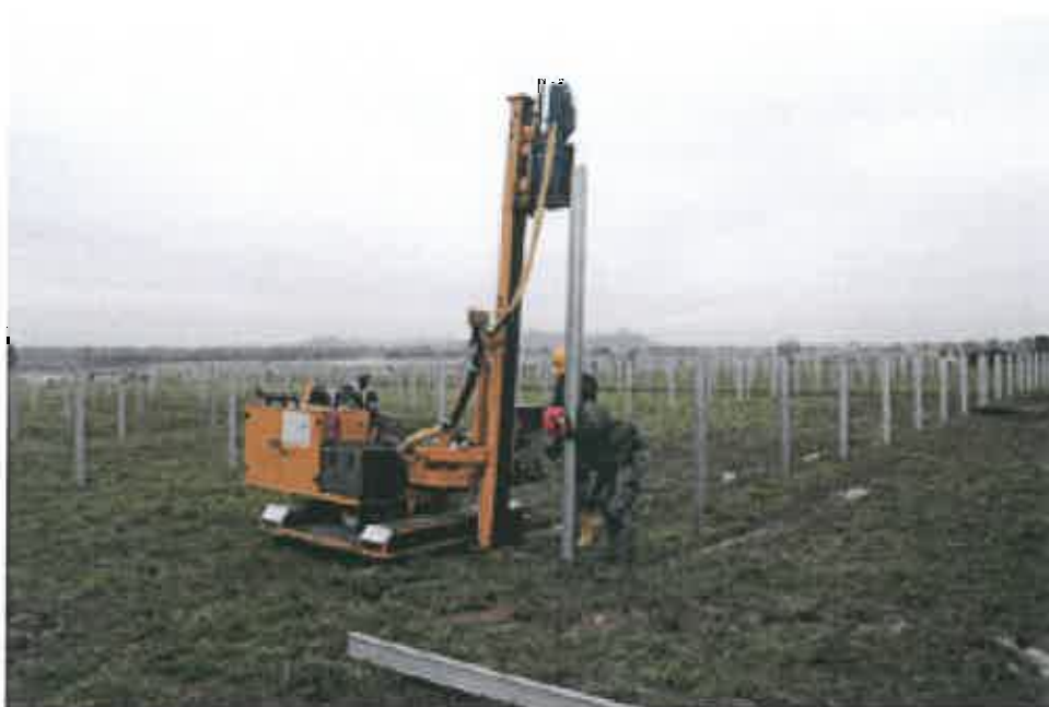
Zdjęcie 2 Montaż profili za pomocą kafara.
