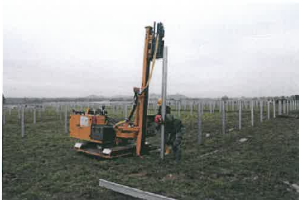
Zdjęcie 2 Montaż profili za pomocą kufara.
