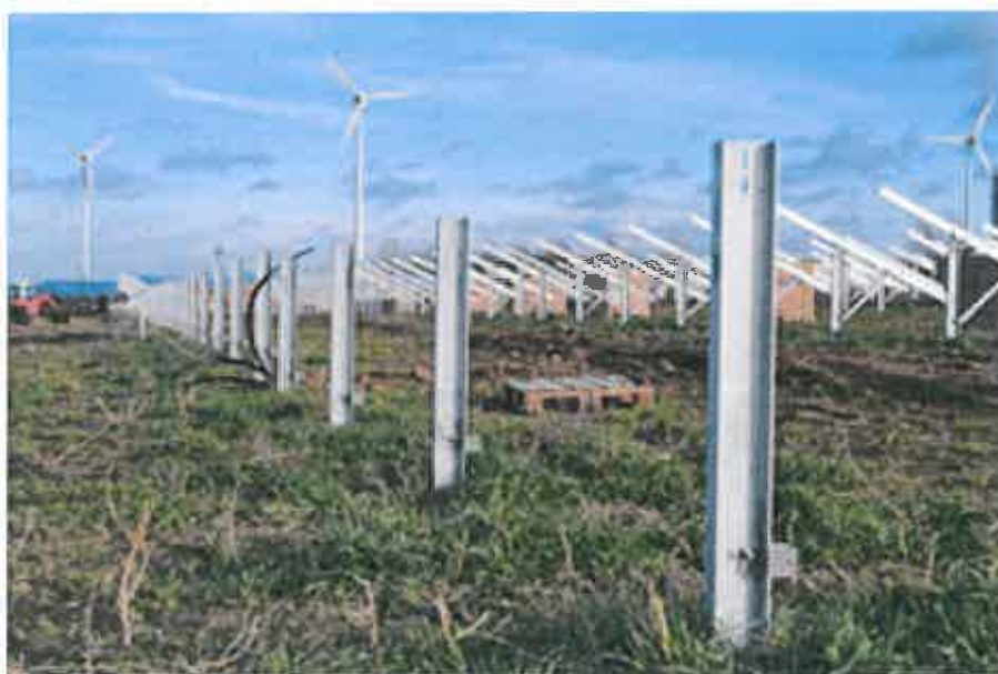
Zdjęcie 1 Profile metalowe: podstawowy element konstrukcji.
