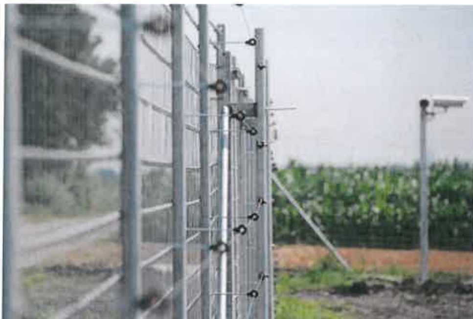
Rysunek 3 Przykładowe ogrodzenie farmy fotowoltaicznej
