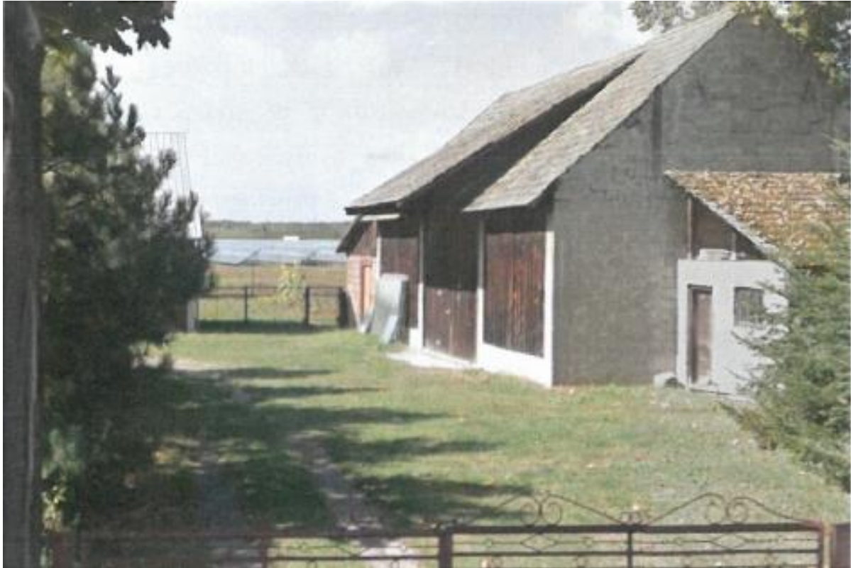
Rycina 16. Widok na instalację fotowoltaiczną z odległości ok. 140 m.
