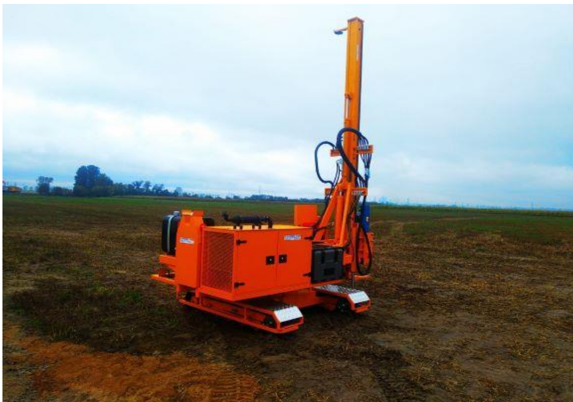
Rycina 4. Budowa konstrukcji za pomocą kafara.
