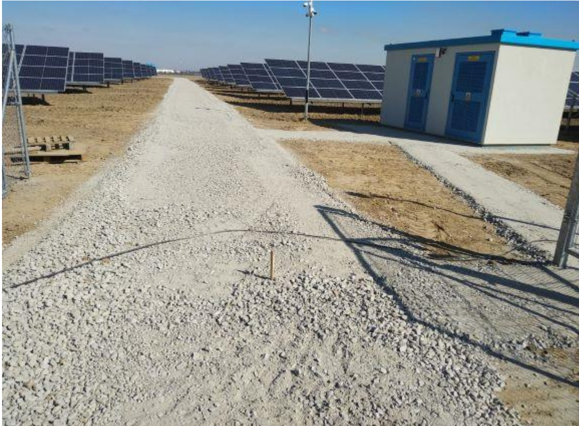
Rycina 1. Przykładowa droga techniczna.
