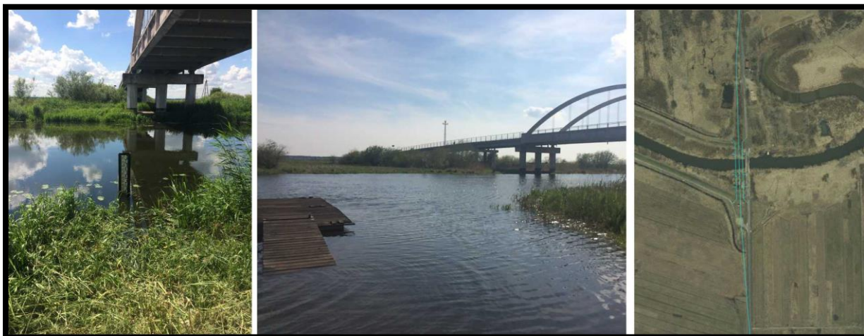
Zdj. 3, zdj. 4, zdj. 5 Istniejący obiekt mostowy – widok od strony wschodniej w okresie średnich i podwyższonych stanów wód (lipiec, maj 2017); Ryc. 2 Planowany nowy przebieg obiektu mostowego na tle zdjęcia lotniczego
